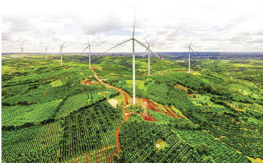
Dự án điện gió tại Đắk Nông
